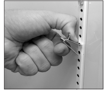
Рис. 2. Нижняя часть кронштейна должна зафиксироваться.
